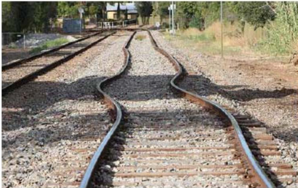
Déformation des rails du RER D lors de la canicule de 2003.
