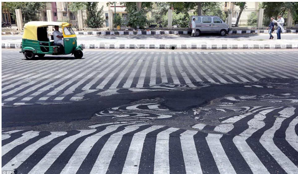
Déformations suite à la fonte partielle de la chaussée à Dehli en Inde en 2015. Source : The Guardian.
