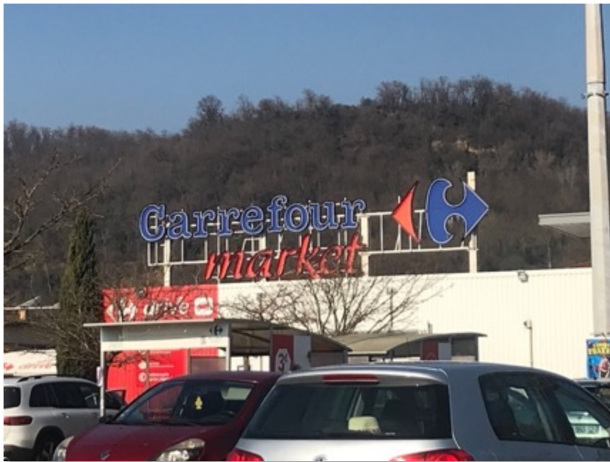
Miribel (structure sur toiture apparente)
